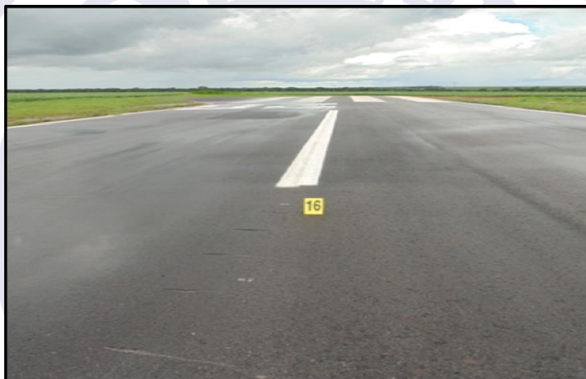
Figura 1 - Marcas das pás de hélice na pista 26 de SSAC.
