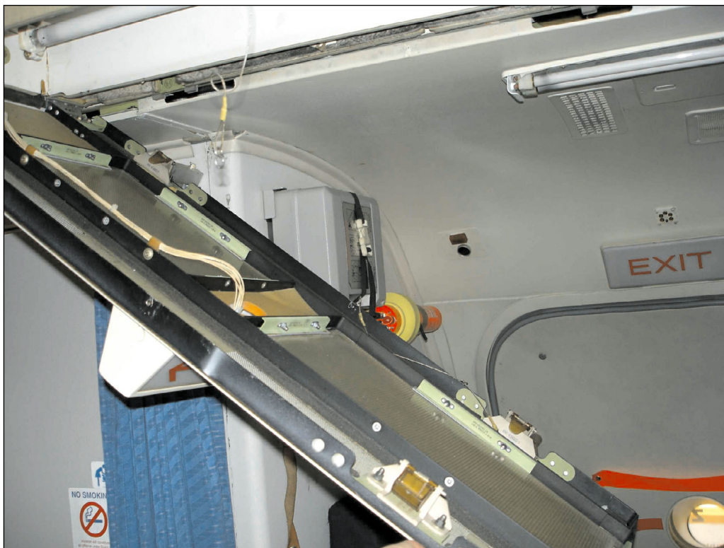
Foto 1.15.1.3. Panel del techo en la parte trasera del compartimiento de asistencia en cabina. Durante la inspección después del accidente se encontró cerrado, pero testigos declaran que se abrió después de que la aeronave se detuvo, obstruyendo el camino hacia las salidas de emergencia L2 y R2, la cinta de sujeción se soltó. El gancho está al final de la unión con la cinta de sujeción
