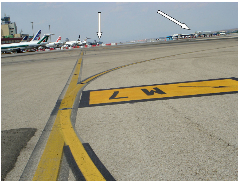
Figura 4. Marca horizontal mostrando el giro a M-7 para los aviones que ruedan en sentido contrario al seguido por el B-747. La zona de obras y el EMB-135 dañado se señalan con flechas blancas
