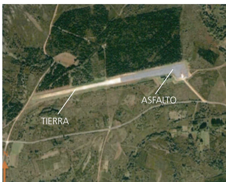
Fig. 4. Pista de la base de extinción de incendios
