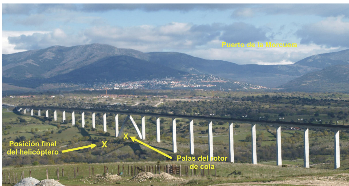
Figura 4. Fotografía del viaducto Arroyo del Valle
