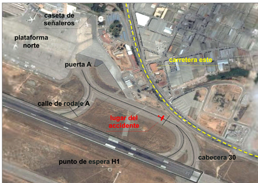
Figura 4. Ubicación del lugar del accidente y de la carretera este
