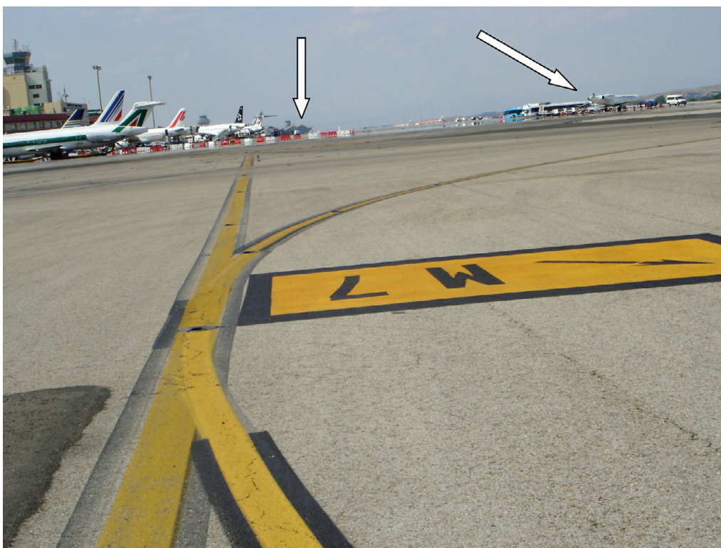
Figura 4. Marca horizontal mostrando el giro a M-7 para los aviones que ruedan en sentido contrario al seguido por el B-747. La zona de obras y el EMB-135 dañado se señalan con flechas blancas
