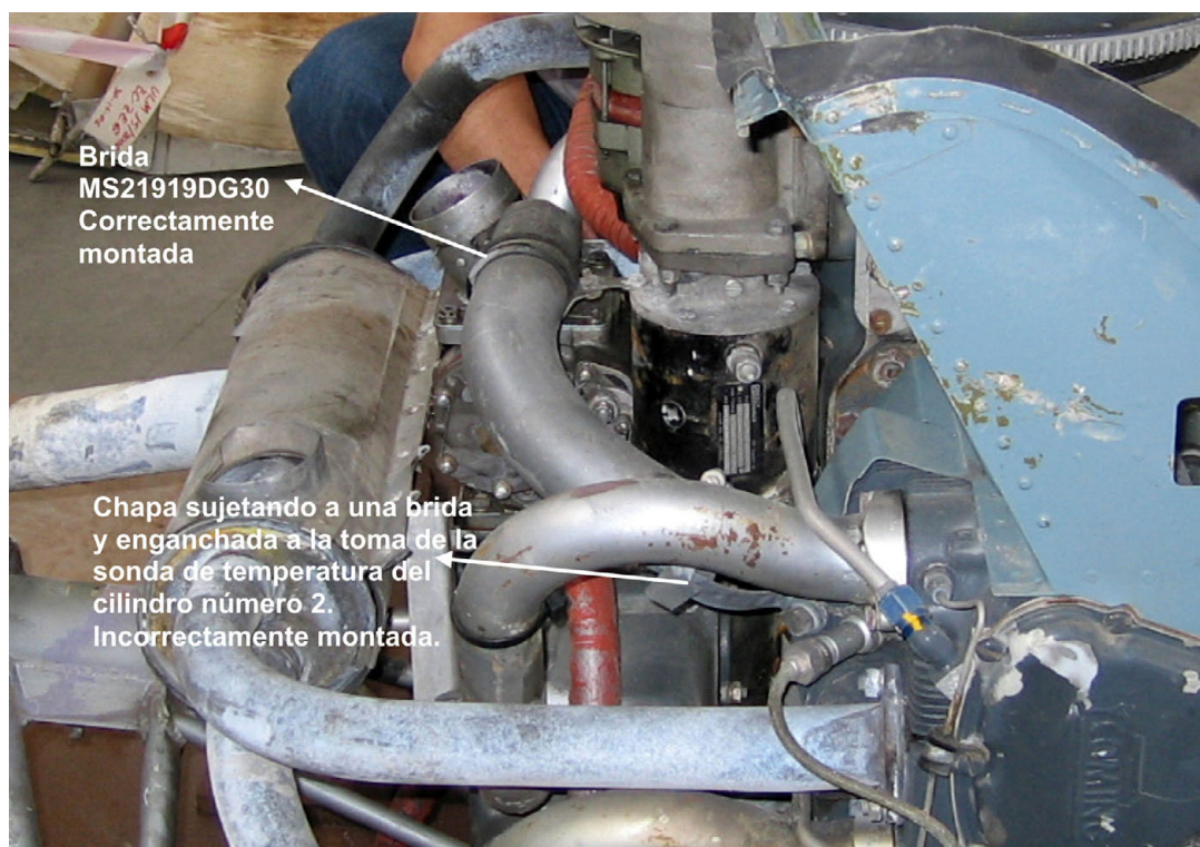
Figura 3. Instalación del tubo de aire alternativo
