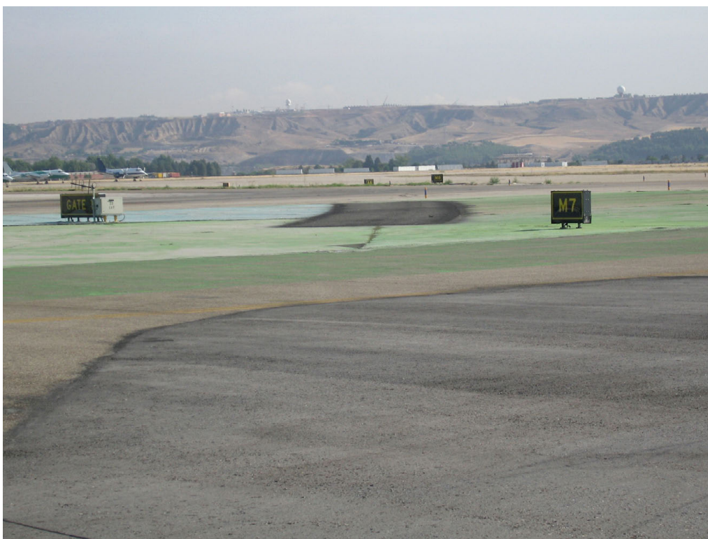
Figura 3. Letreros verticales de M-7 y GATE 1 vistos a nivel del suelo desde la intersección M-6/M-7
