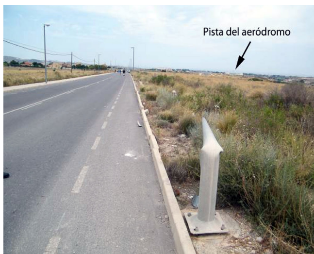
Figura 4. Estado final de la farola A
