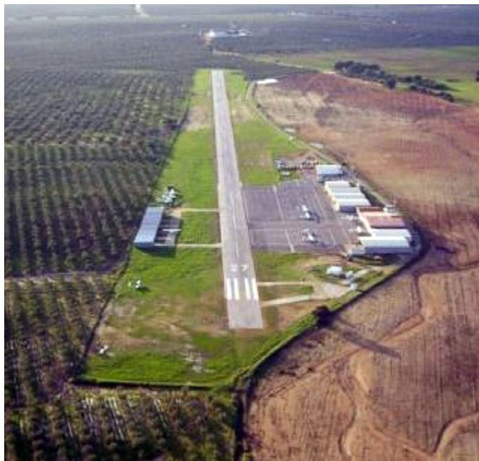
Figura 2. Vista aérea de La Juliana
