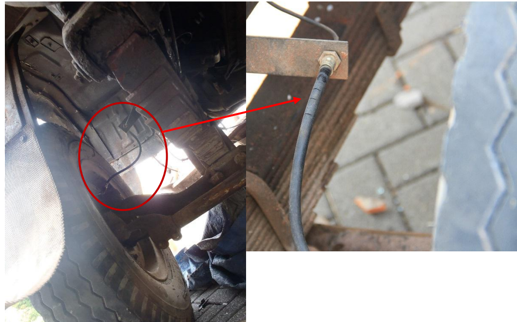
Rubber flexible hose di sumbu depan kiri mengalami penuaan dan bocor
