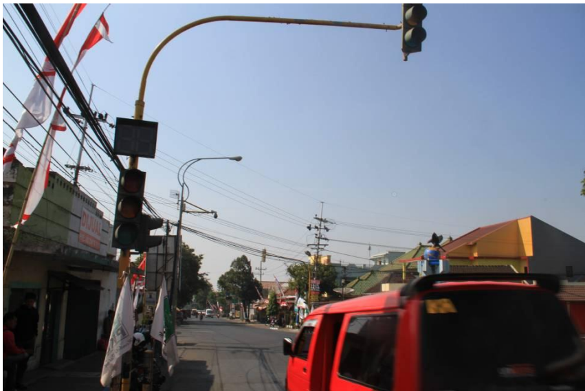
APILL tidak berfungsi ± 300 m sebelum lokasi
