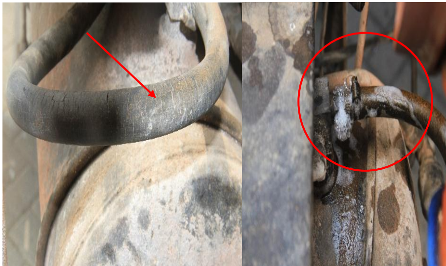
Kondisi synthetic air hose mengalami penuaan dan bocor
