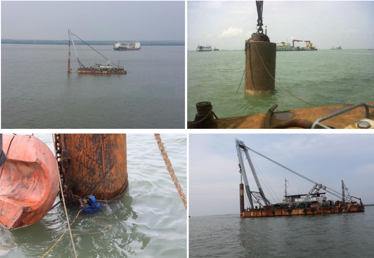
Gambar I-28: Operasi pengangkatan Spud MV. DBD Caijun I pada Januari 2015
