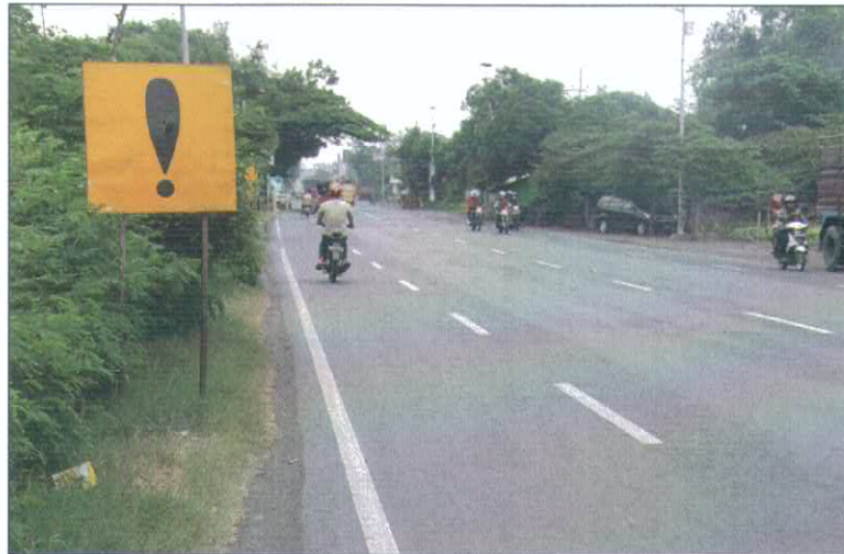
Gambar 4. Kondisi rambu-rambu lalu lintas di Jalan Raya Tongas Ruas Jalan Pasuruan – Probolinggo KM. SBY 86-87
