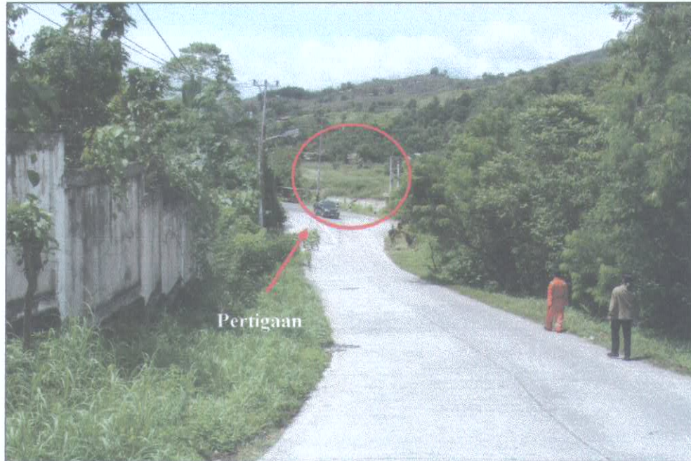
Gambar 3. Kondisi jalan alternatif Perumnas III Waena – Entrop 100 m menjelang pertigaan lokasi TKP.
