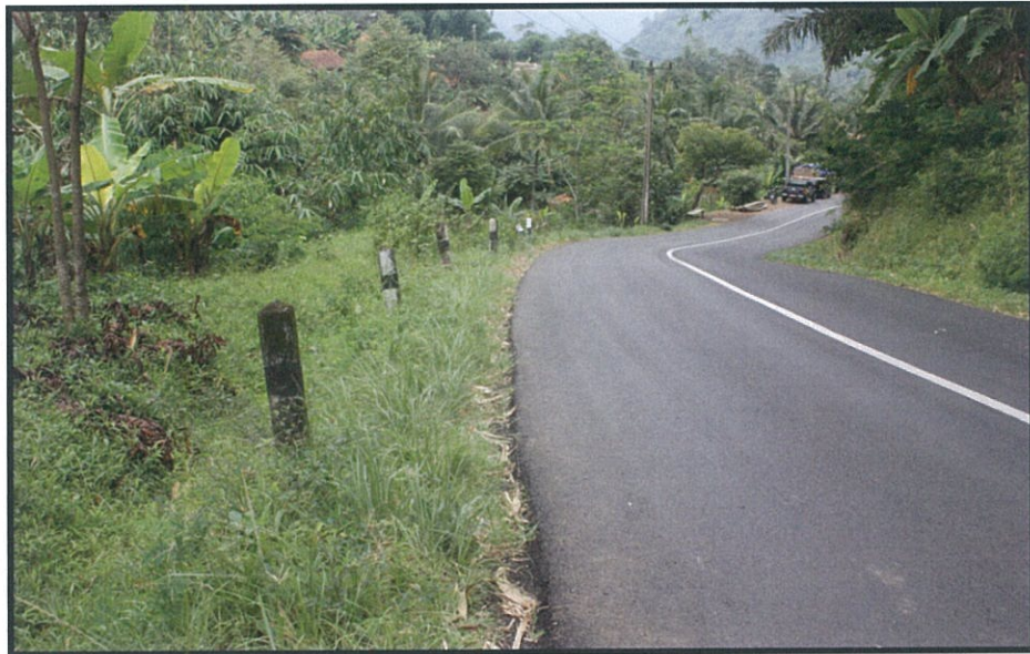
Gambar 2. Tikungan terakhir sebelum mobil bus PO. Maju Jaya masuk ke jurang
