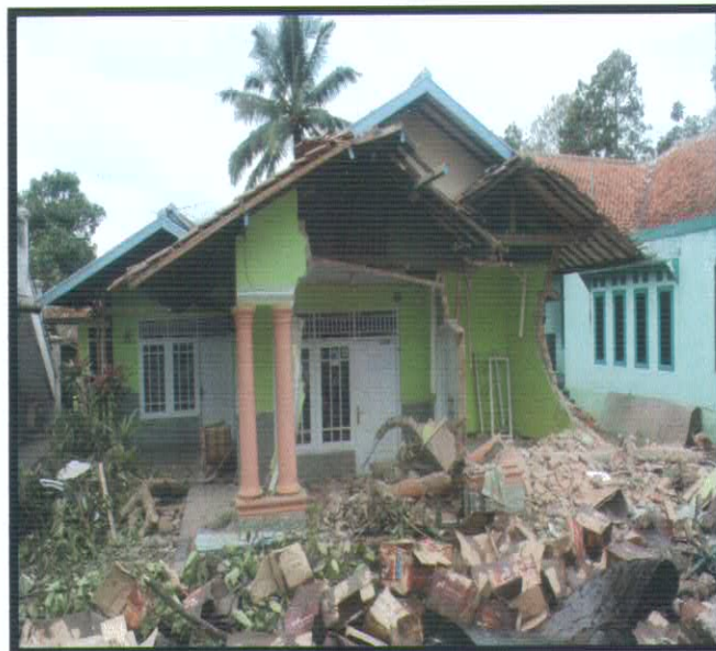
Gambar 1. Kondisi rumah yang ditabrak mobil barang truk sumbu ganda (box) L-9763-UA
