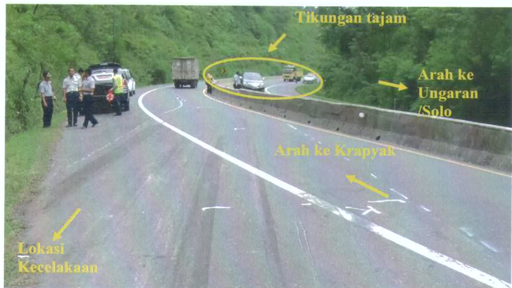
Gambar 5. Lokasi tikungan tajam 50 m sebelum lokasi kecelakaan.
