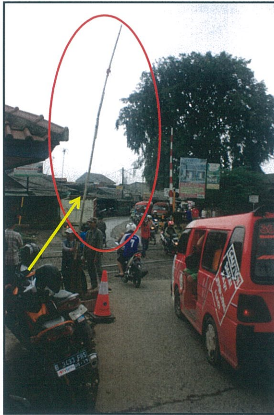
Gambar 7. Palang pintu perlintasan dari arah Cibitung menuju Tambelang terbuat dari bambu
