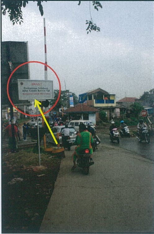
Gambar 10. Rambu peringatan bahwa ada perlintasan sebidang jalur ganda dalam kondisi baik (arah Tambelang menuju Cibitung)
