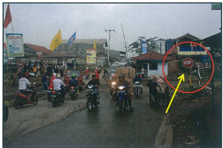
Gambar 7. Palang pintu perlintasan dari arah Cibitung menuju Tambelang terbuat dari bambu
