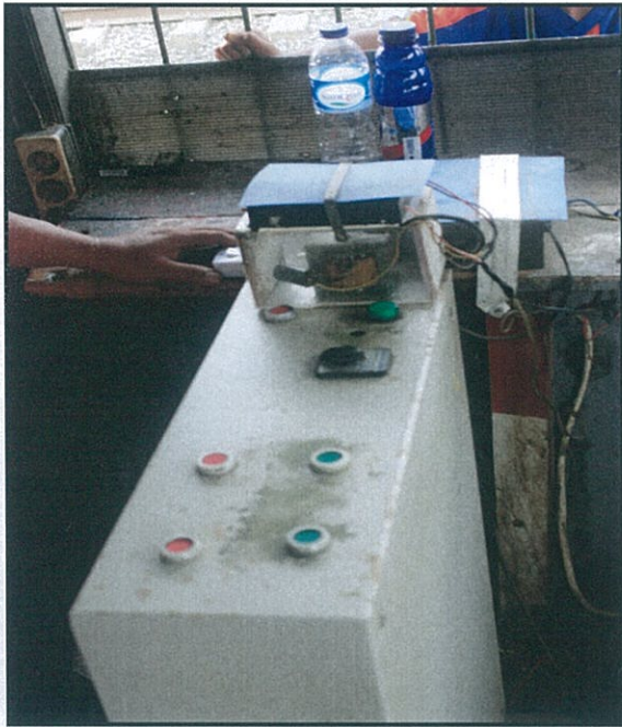
Gambar 1. Sirine yang berada di dalam Pos Penjaga Palang Pintu Perlintasan merupakan rakitan sendiri
