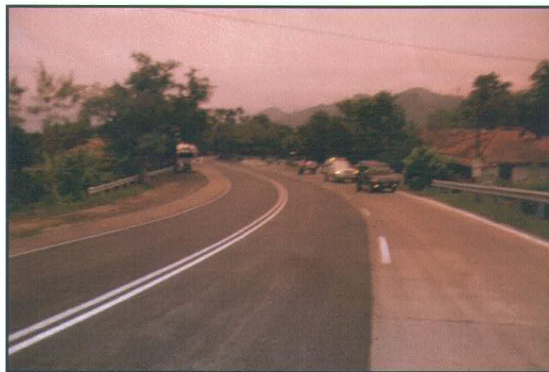
Gambar 3. Kondisi Jalan Raya Sumedang - Cirebon
