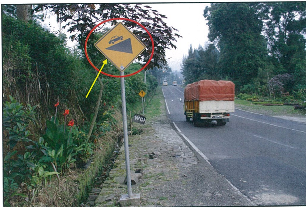
Gambar 8. Rambu tanjakan ruas jalan Cicenang, Subang arah menuju Bandung
