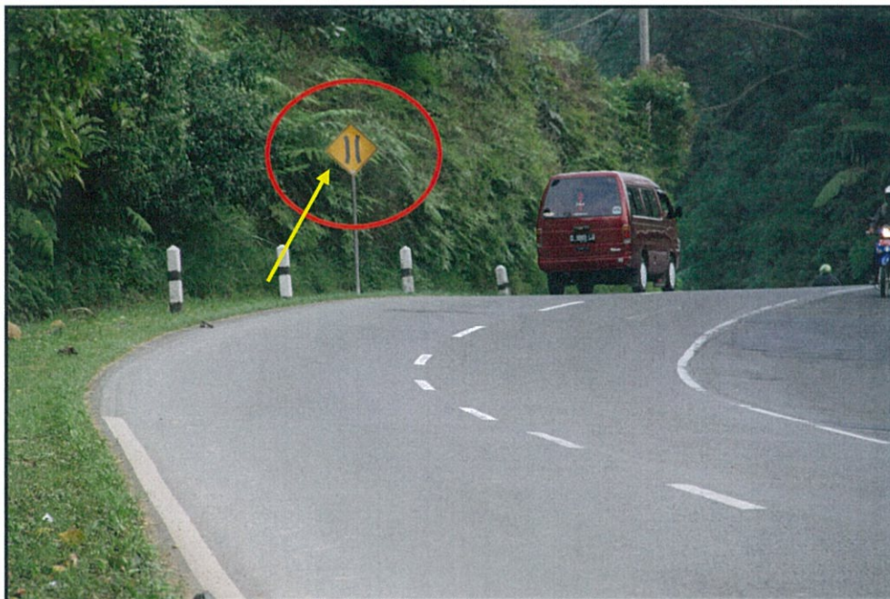
Gambar 10. Rambu jembatan sempit ruas jalan Cicenang, Subang arah menuju Bandung
