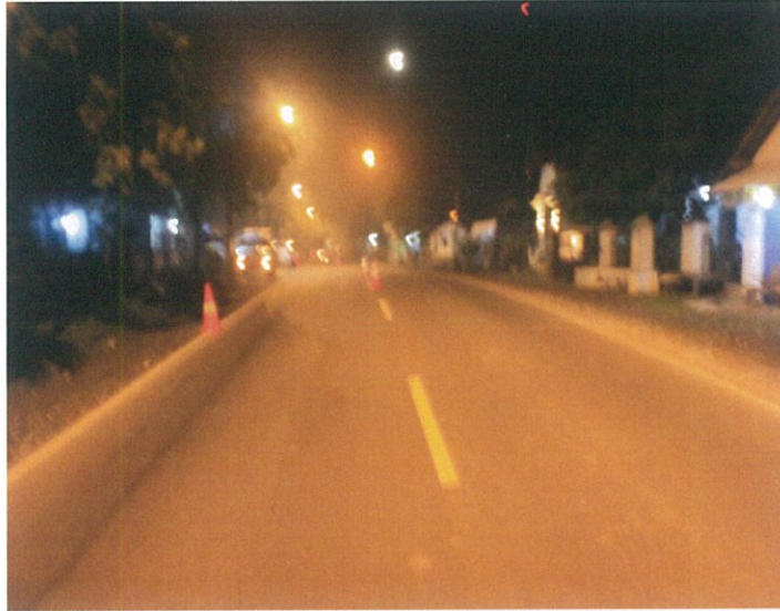
Gambar 1. Kondisi Jalan Cukup Baik dan Perlengkapan Jalan Lengkap
