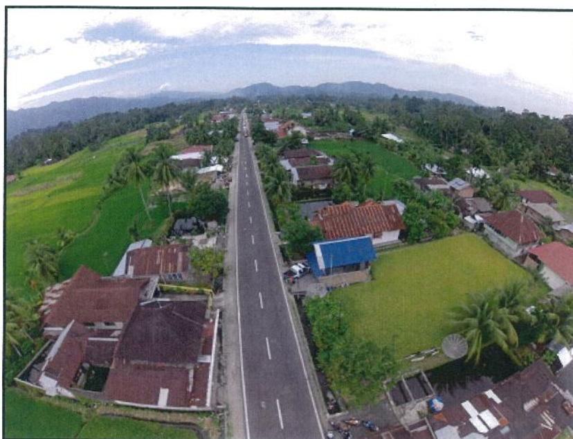
Gambar 4. Ruas jalan di km 56.700 Pasar Guguak Kayu Tanam Kabupaten Padang Pariaman
