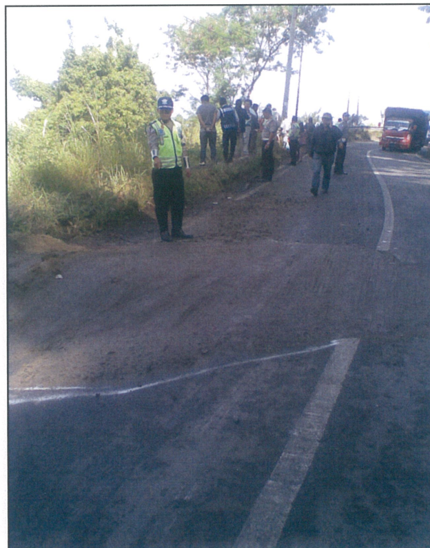
Gambar 2. Gundukan material yang menyita badan jalan
