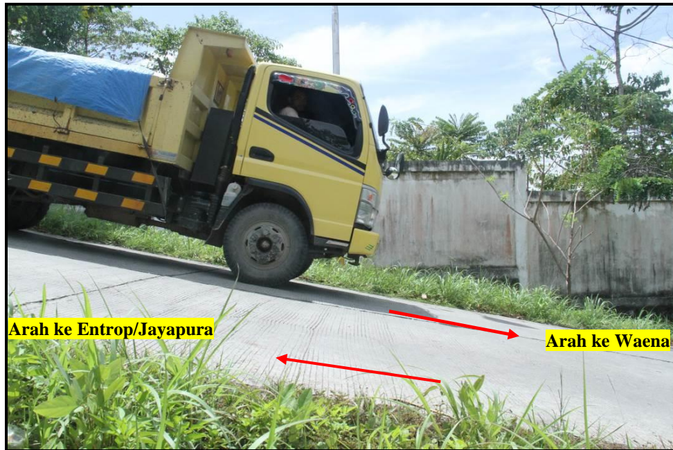
Gambar 13. Kondisi ruas jalan alternatif Perumnas III Waena – Entrop menurun dengan kemiringan vertikal \pm 10^{\circ} - 12^{\circ}
