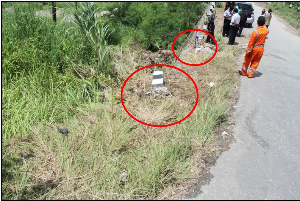
Gambar 11. Kondisi tiang-tiang pembatas (delineator) jalan yang patah dan roboh akibat tertabrak oleh mobil barang dump truck DS-9675-AB.
