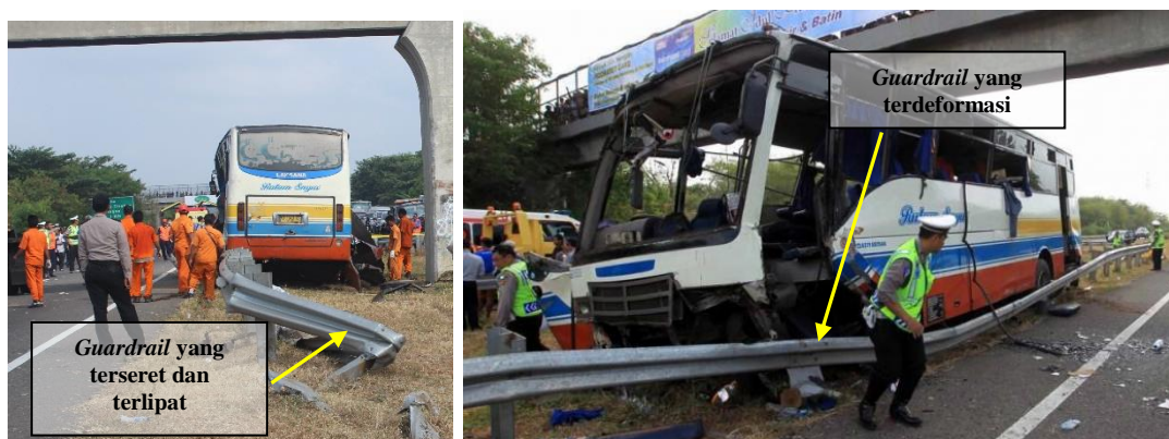
Gambar 17. Kondisi guardrail akibat tertabrak oleh mobil bus.
