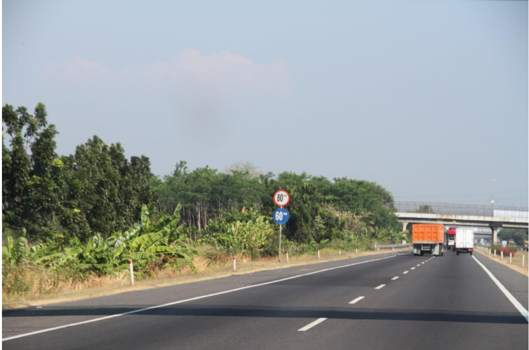
Gambar 20. Rambu batas kecepatan 2 km sebelum lokasi terjadinya kecelakaan.
