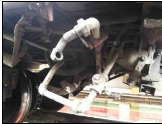
Gambar 13. Pipa sistem udara saluran pengereman patah
