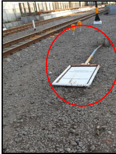
Gambar 18. Papan himbauan milik Kementerian Perhubungan yang roboh
