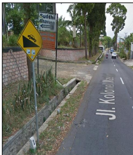
Gambar 16. Kondisi rambu peringatan menurun
