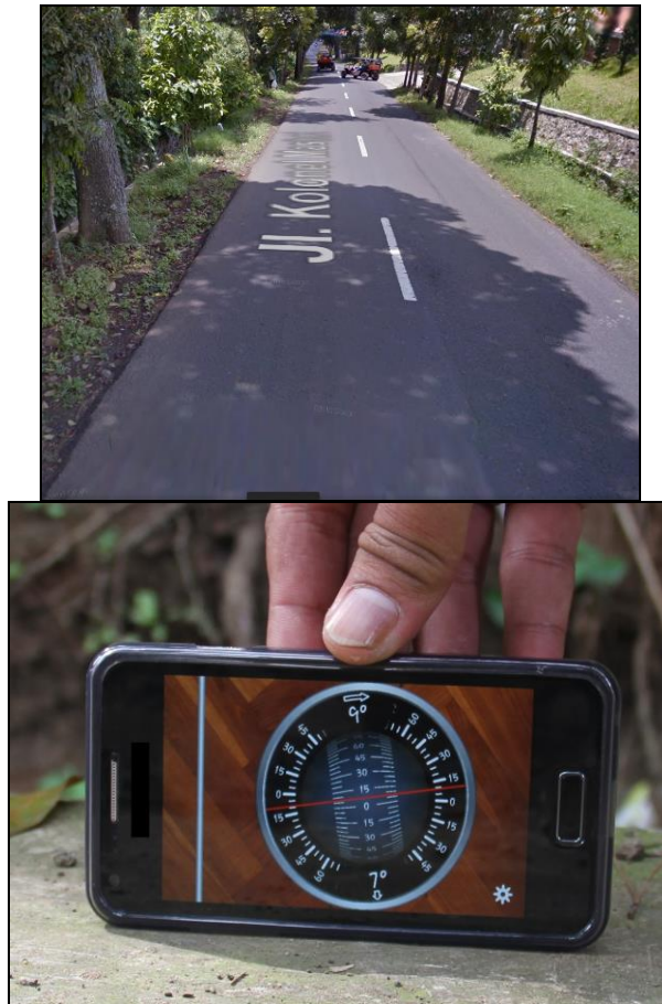
Gambar 15. Kondisi Jalan Turunan
