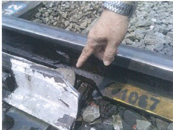
Gambar 3. Lidah Wesel 23 yang tertabrak oleh roda KRL yang anjlok
