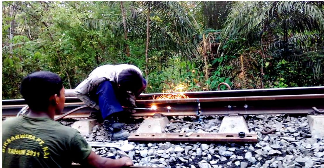
Pelubangan rel menggunakan las pijar
