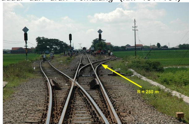
Emplasemen Suradadi dilihat dari arah Larangan dengan lengkungan R 280 m pada sepur 3
