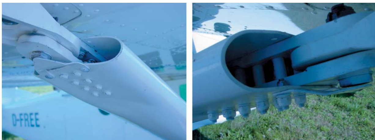
Foto n. 18: soluzioni installative del tronco di controventatura su altro Pilatus PC6 B2-H2
