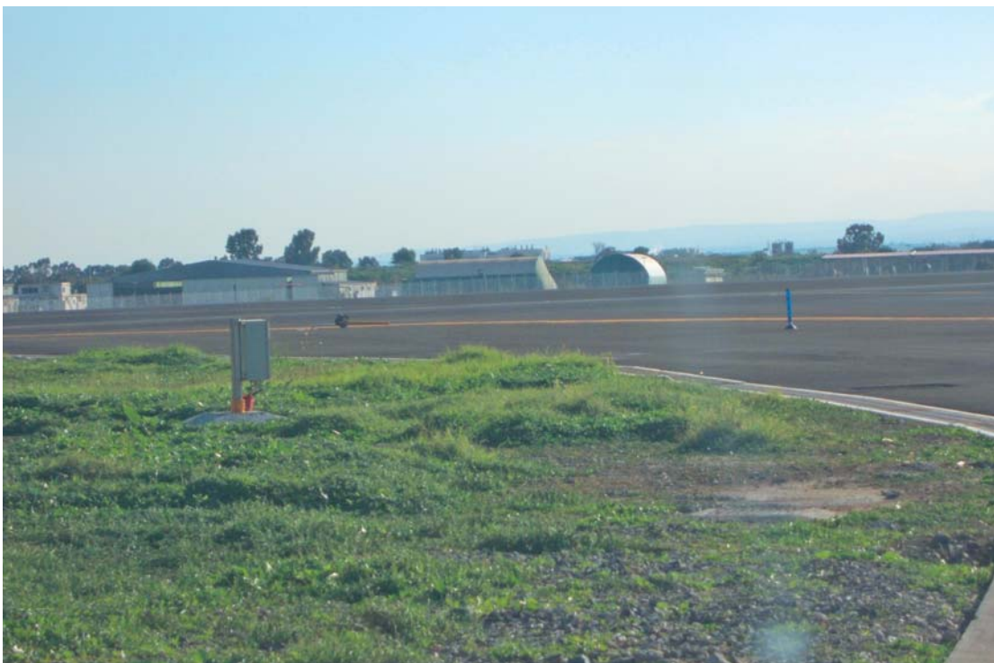
Panoramica della zona dell'incidente, con paletto abbattuto.
