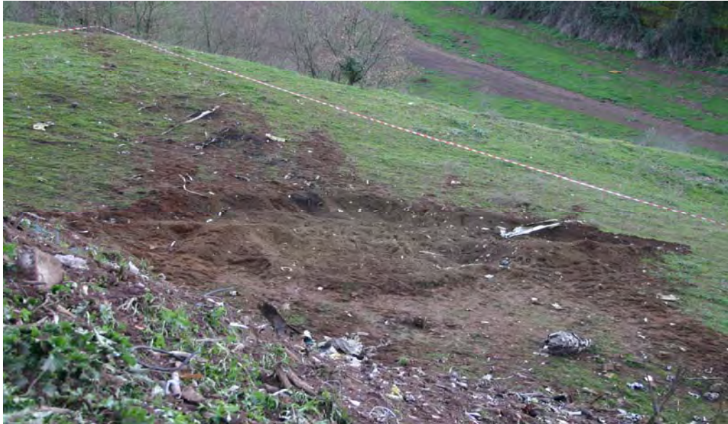
Foto 18: primo piano del cratere di impatto visto dalla sommità del terrapieno.
