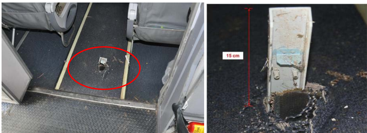
Foto 38: particolare del cross beam FR65.
