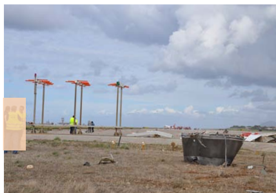
Foto 17: la stessa antenna dopo l'impatto.
