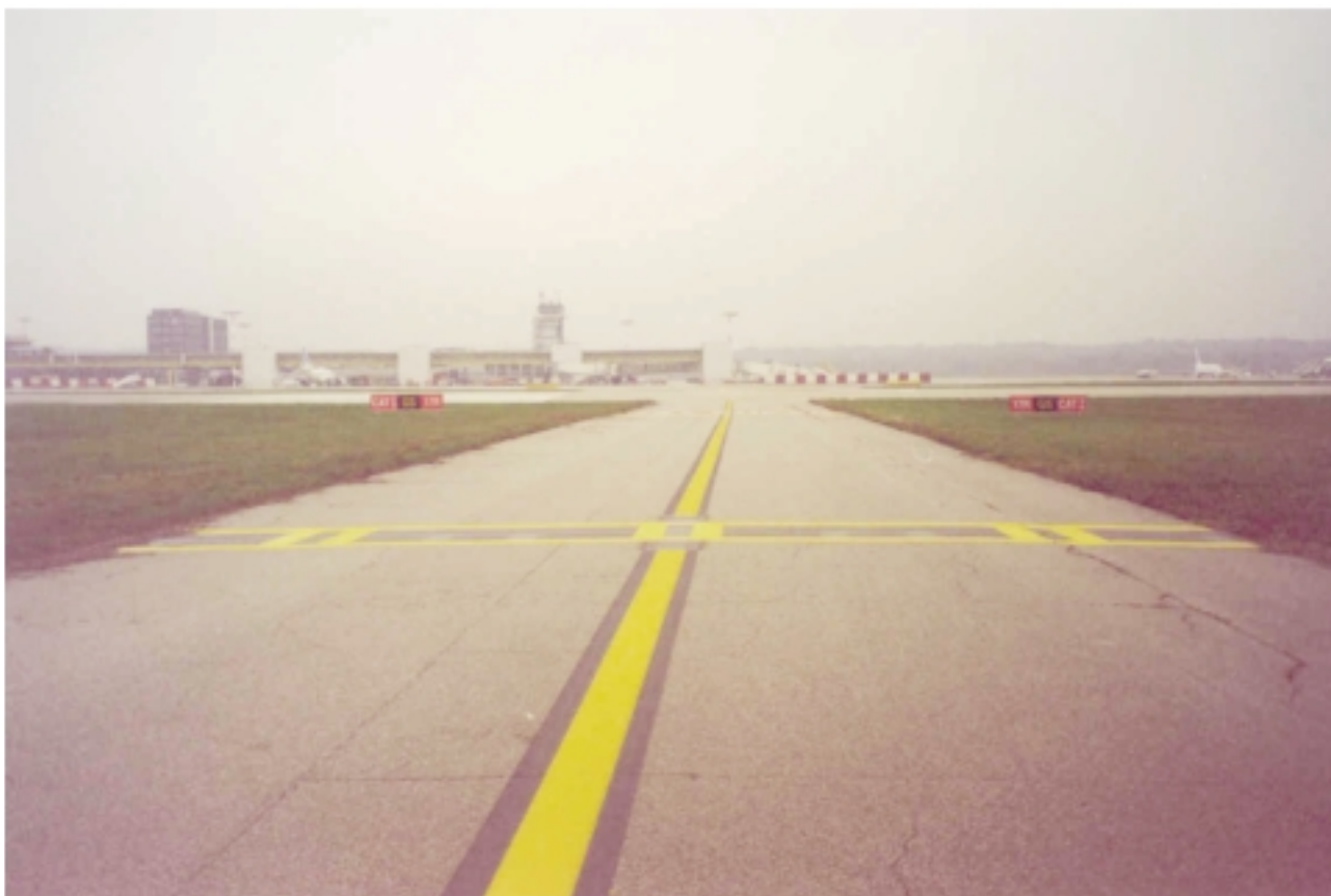
Raccordo GS - Segnaletica orizzontale priva delle indicazioni luminose previste per operazioni con bassa visibilità
