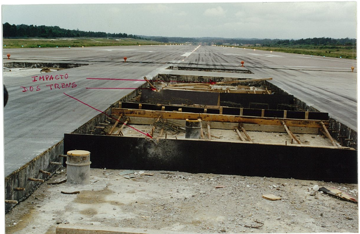
CAIXA DE OBRAS NA PISTA 35
