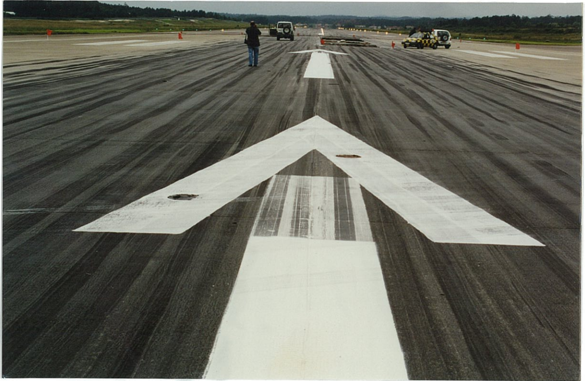
PISTA 35 - ZONA DE OBRAS E MARCAÇÕES
