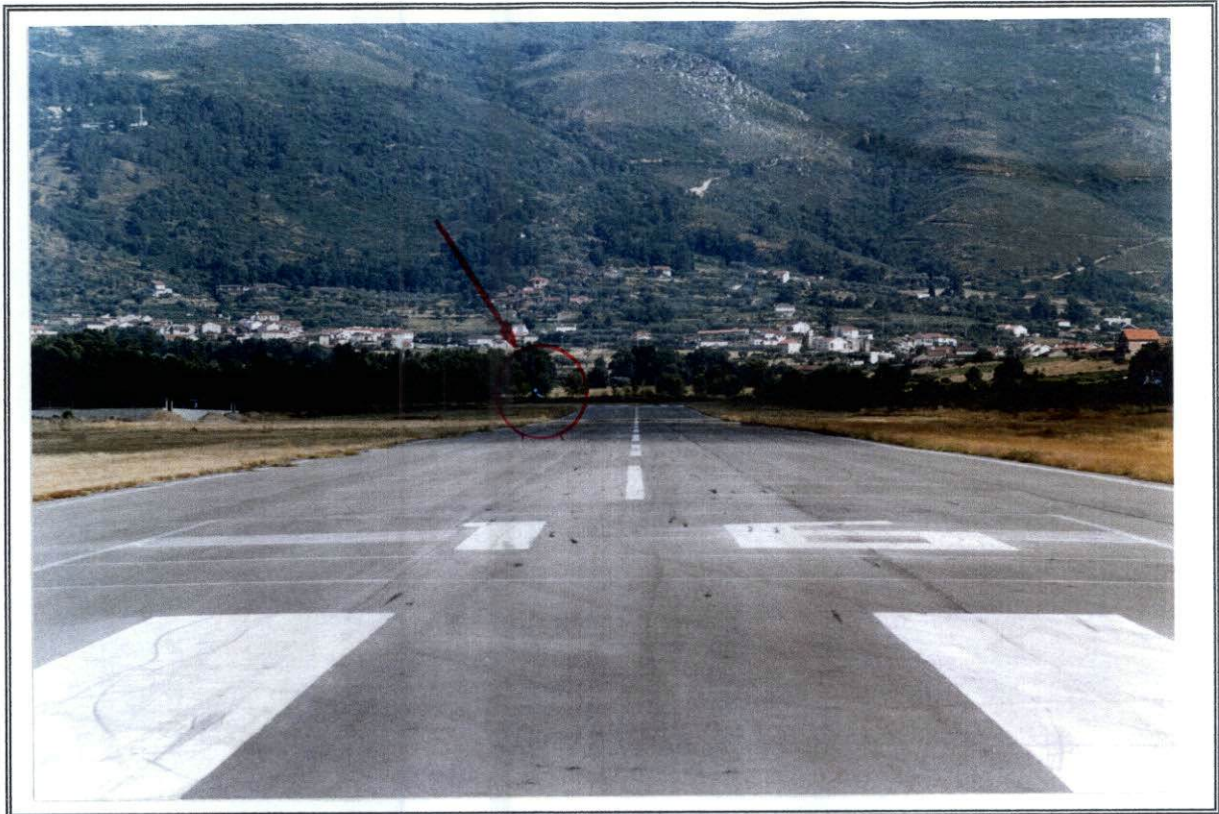
PONTO DE QUEDA DO AVIÃO
