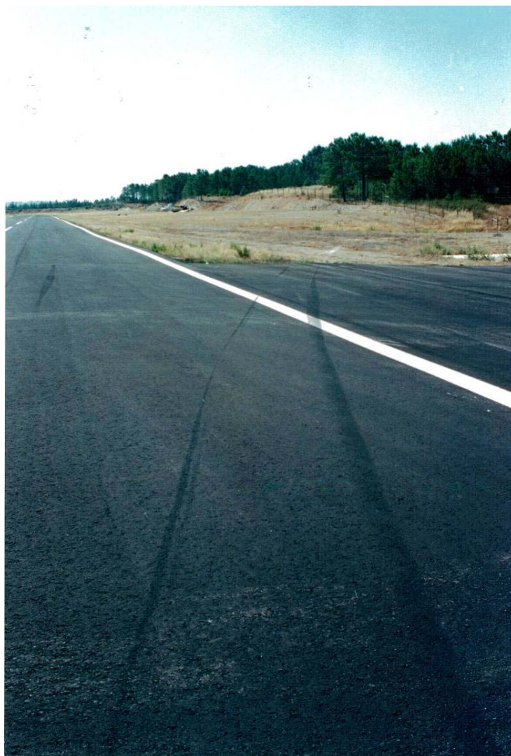
FOTO 6 – MARCAS DOS PNEUS DO TREM PRINCIPAL NA PISTA ASAFALTADA INFLECTINDO PARA A DIREITA EM DIRECÇÃO À LAGOA – PORMENOR 15JULHO2002
