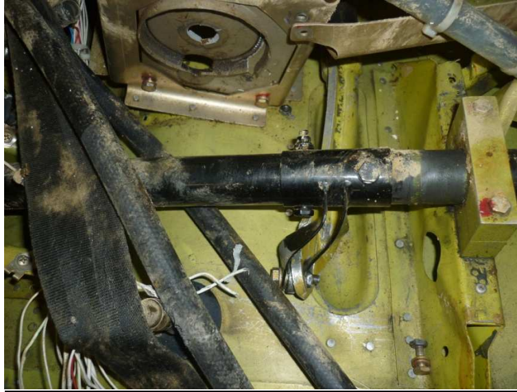
Fig. 13 – Pormenor do estado de deformação da ferragem de fixação do parafuso sem-fim ao tubo de torção de accionamento dos flaps.
