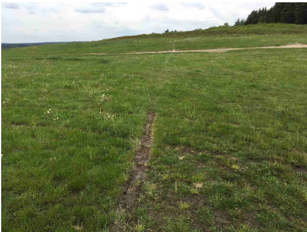
Obr. 8 Vydřený povrch RWY při dojezdu letounu se zavřeným předovým podvozkem
