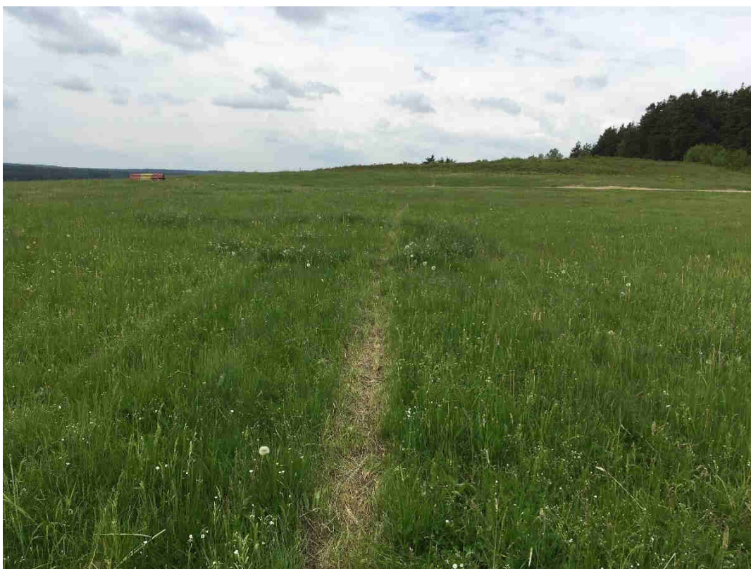
Obr. 8 Vydřený povrch RWY při dojezdu letounu se zavřeným předovým podvozkem
