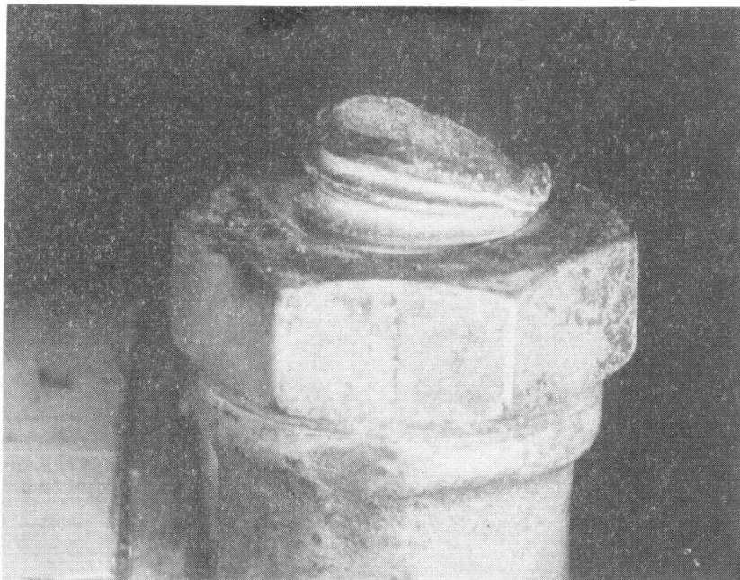
Ansicht des Bruchbereiches mit deutlichen Deformationserscheinungen
